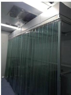
洁净棚（净化工作站、净化棚、无尘操作亭、CLEAN BOOTH）：材料以工业铝材（或不锈钢方管、铁方管喷塑）作为框架，采用风机滤网机组送风，四周围用防静电垂帘（或钢化玻璃），内部净化级别可达100-100000级；特别适用于车间内局部净化级别要求高的区域，如流水线作业区域。特点：1、组装式结构设计，安装方便，大大缩短了交货周期；2、移动方便（可装万向轮）；3、模块化结构，提高净化级别容易，扩展性强，且重复利用价值高；4、相对风机过滤送风单元，内部可用有效空间大；相对传统无尘室，成本低、施工快、且对楼层高度要求低。
